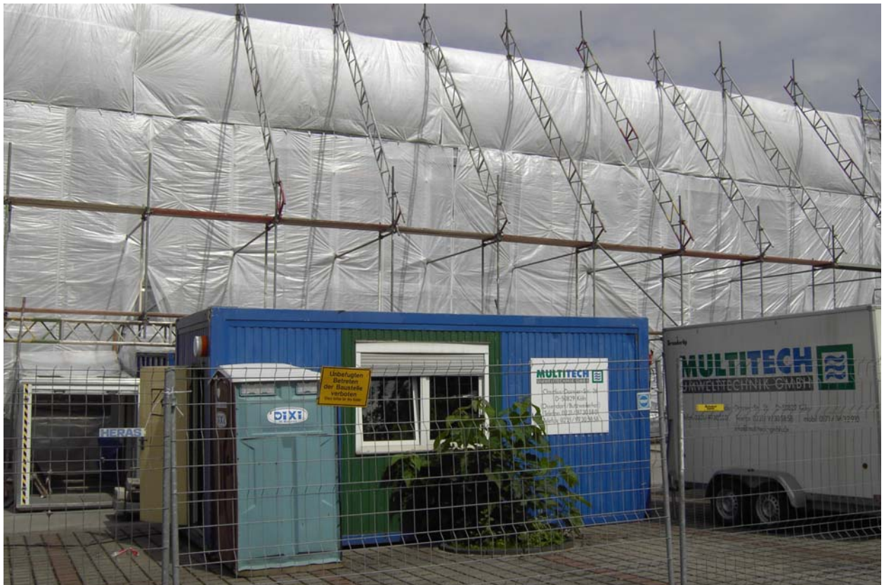
Baustelleneinrichtung inkl. Materialschleuse für Spritzasbestsanierung im Außenbereich
