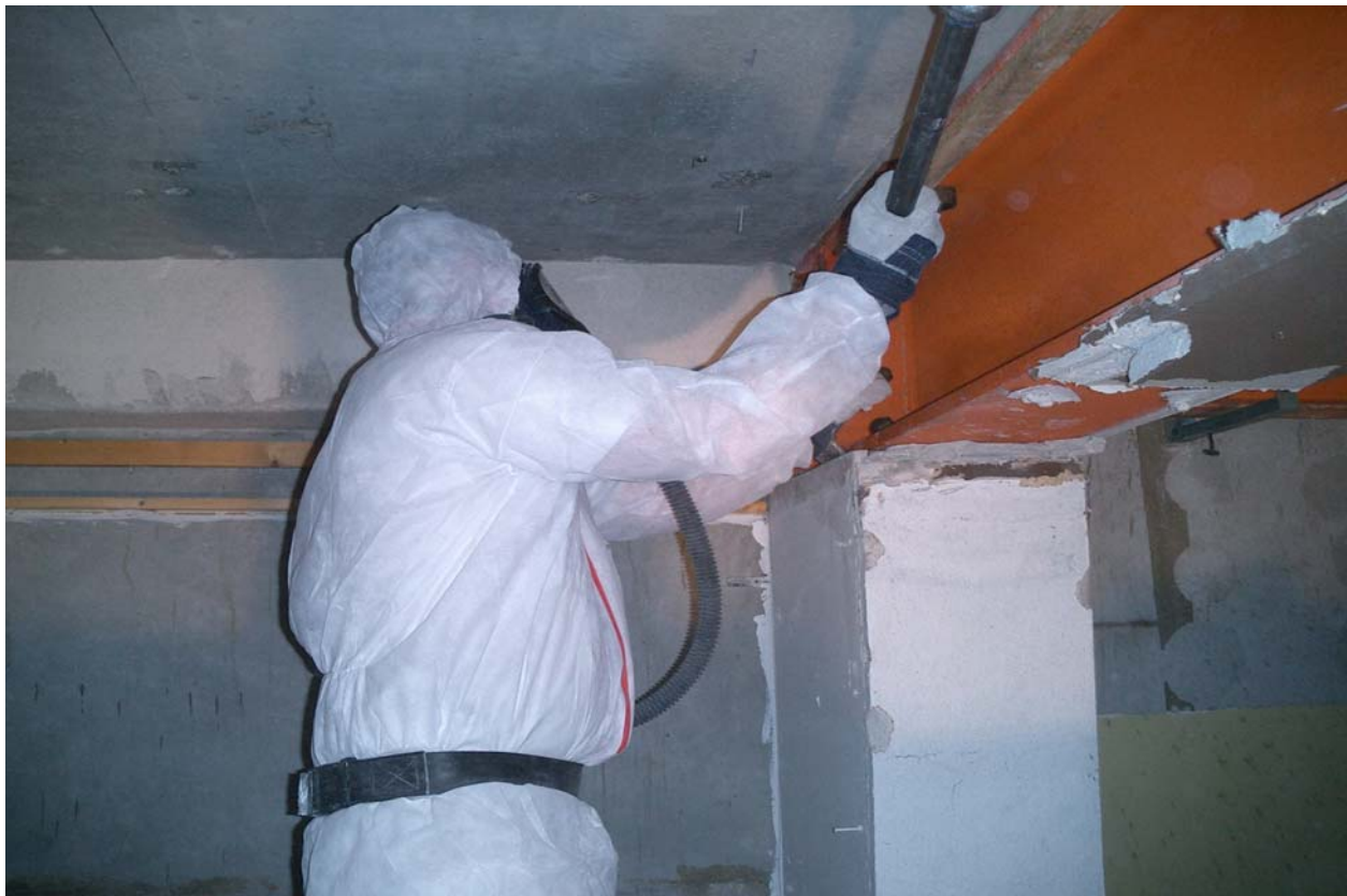
Spritzasbestsanierung unter Vollschutz
