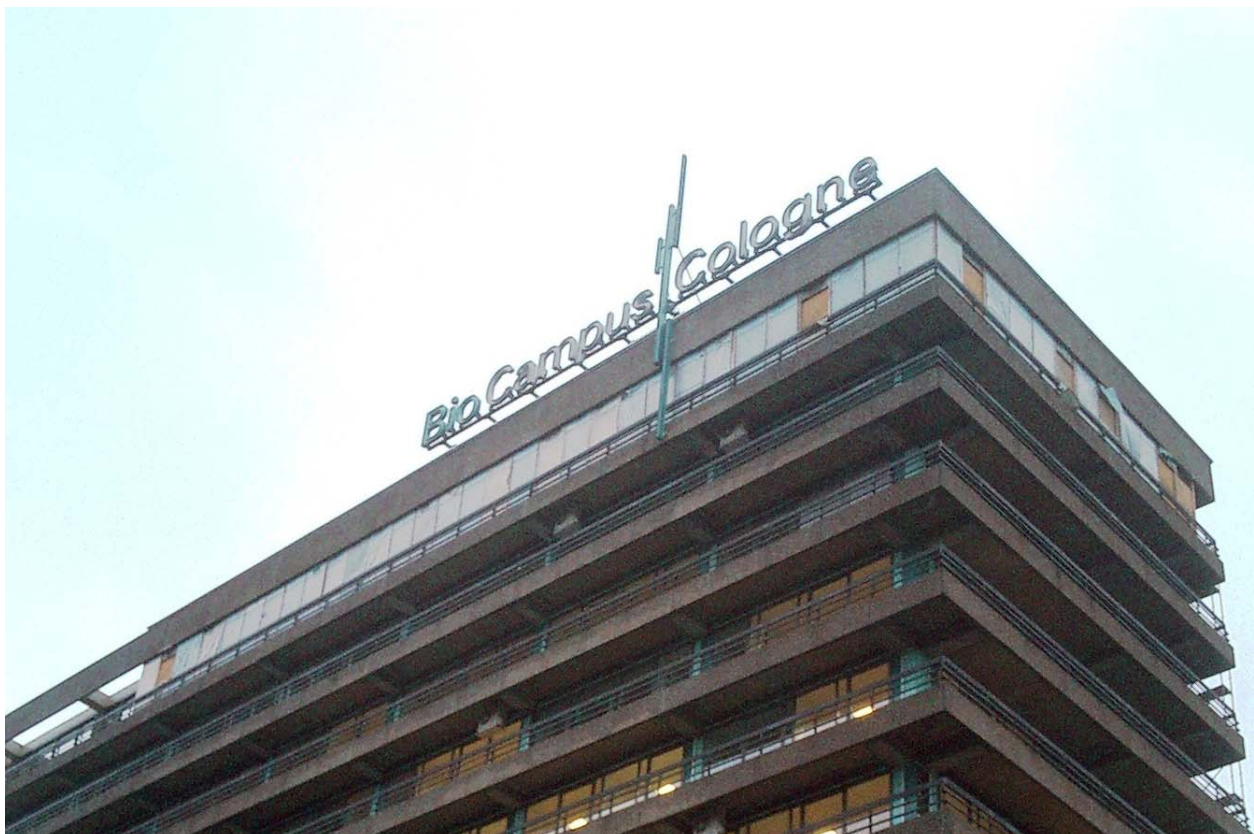
Einhausung einer kompletten Etage inkl. Balkon im laufenden Bürobetrieb
