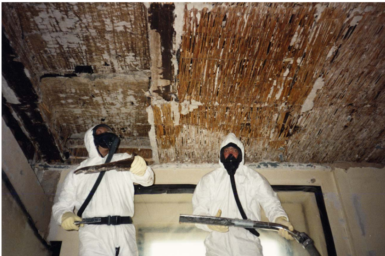
KMF- / Asbest Deckensanierung unter Vollschutz
