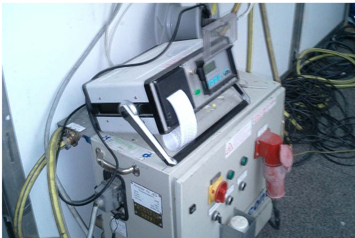
Unterdruckschreiber zur Kontrolle der Unterdruckhaltung
