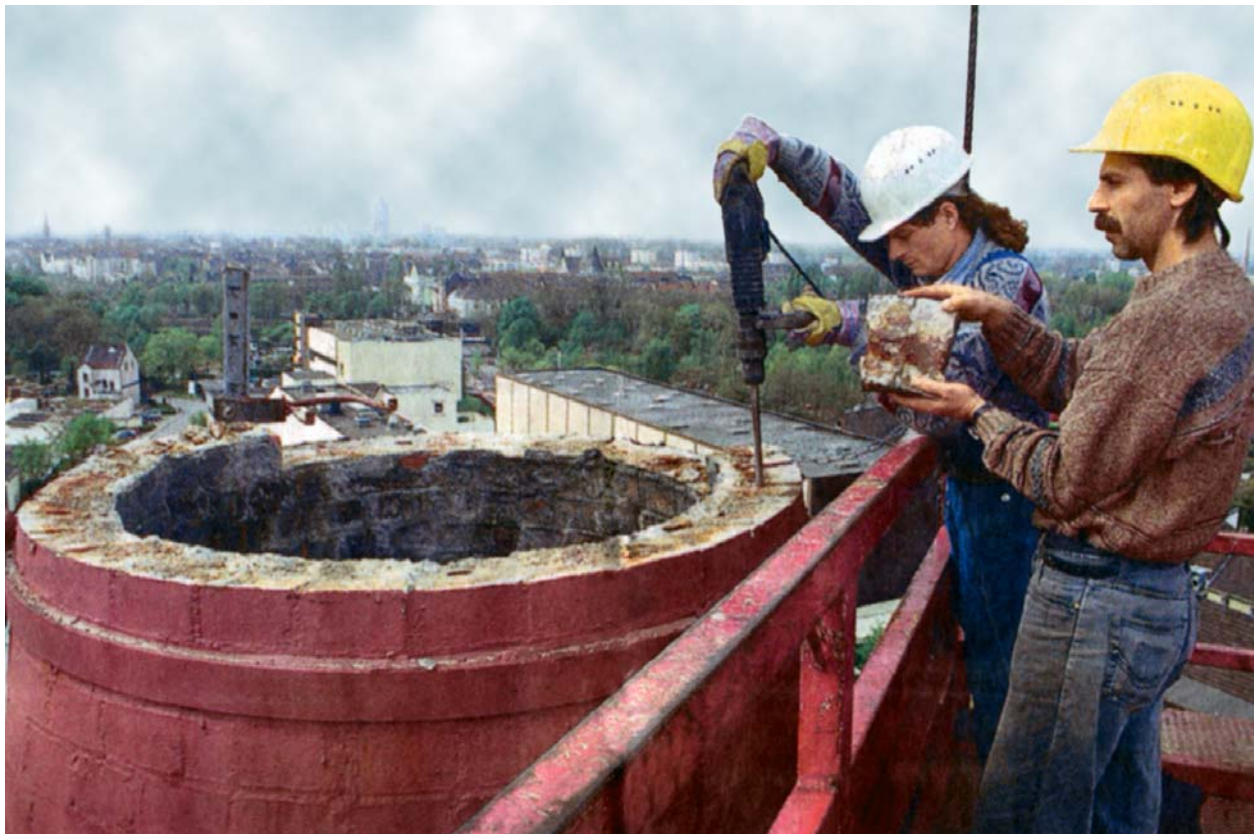
Schornstein-Handabbruch zur Minimierung der Gefahren für angrenzende Wohngebiete
