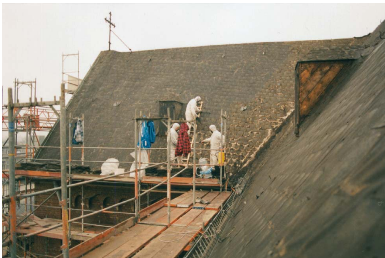
Schadstoffsanierung auf Kirchendach
