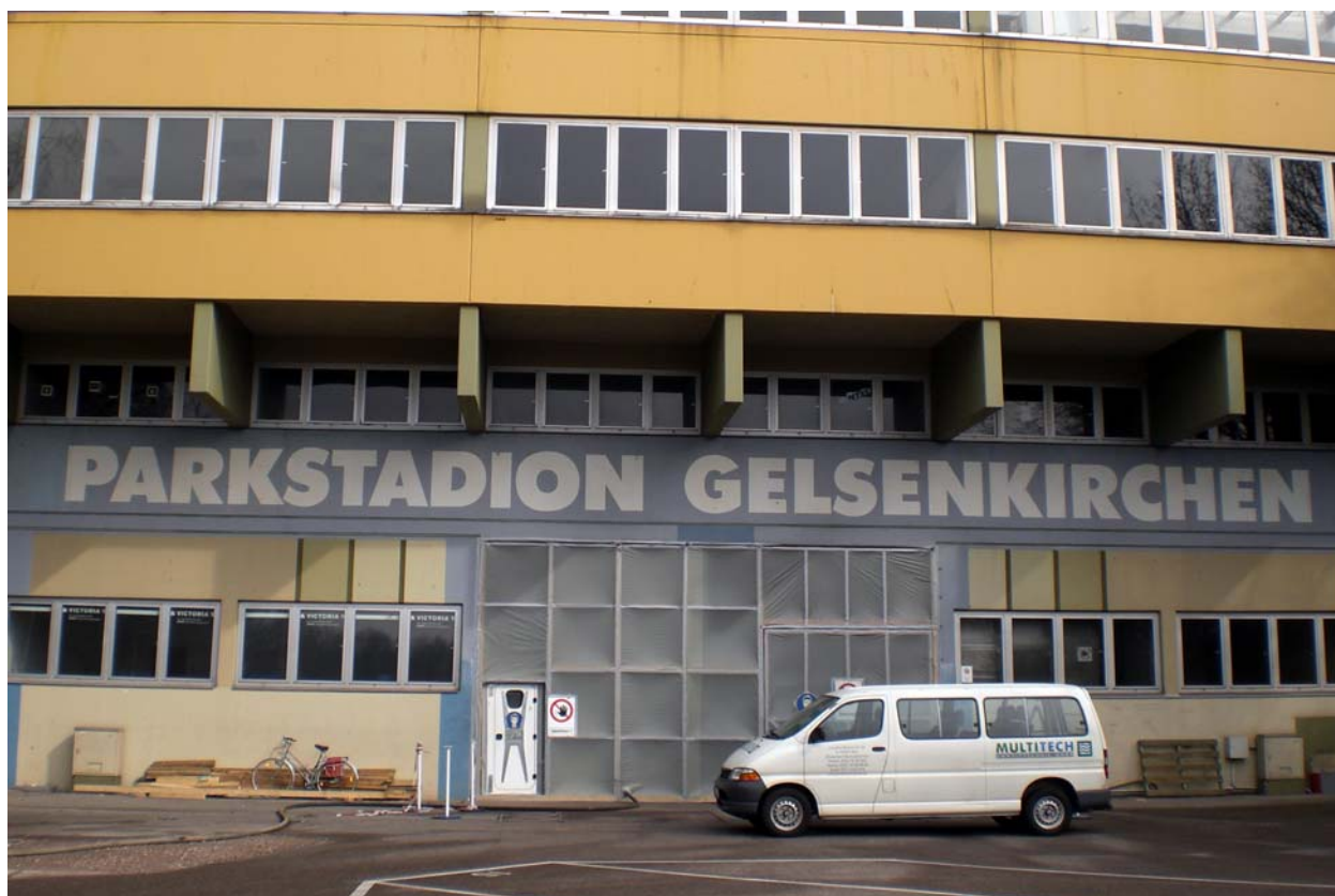
Schadstoffsanierung des gesamten Stadions vor Abbruch
