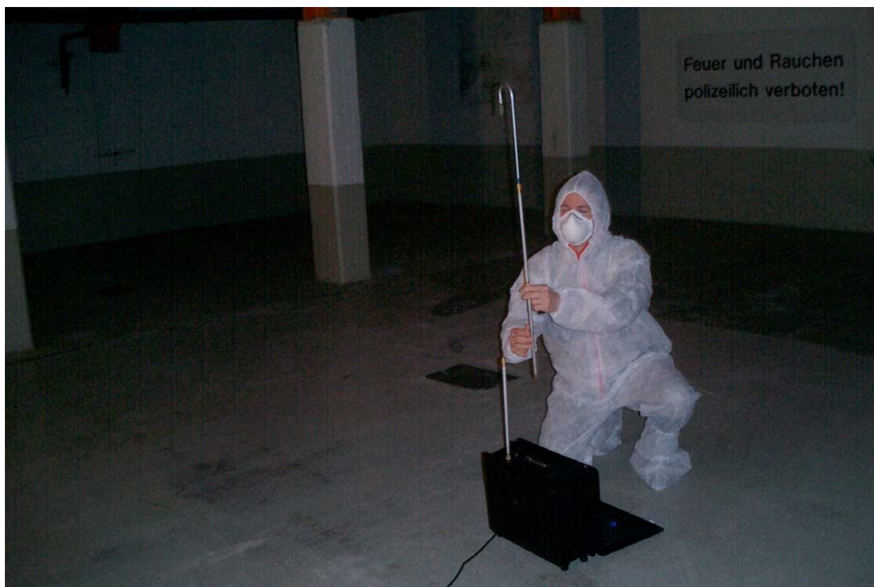
Aufstellung einer Luftraummessung nach der Sanierung
