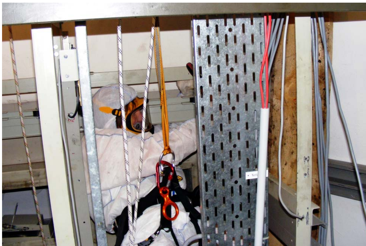
Sanierungsarbeiten in Schachtbereich mit Industrieklettergeschirr
