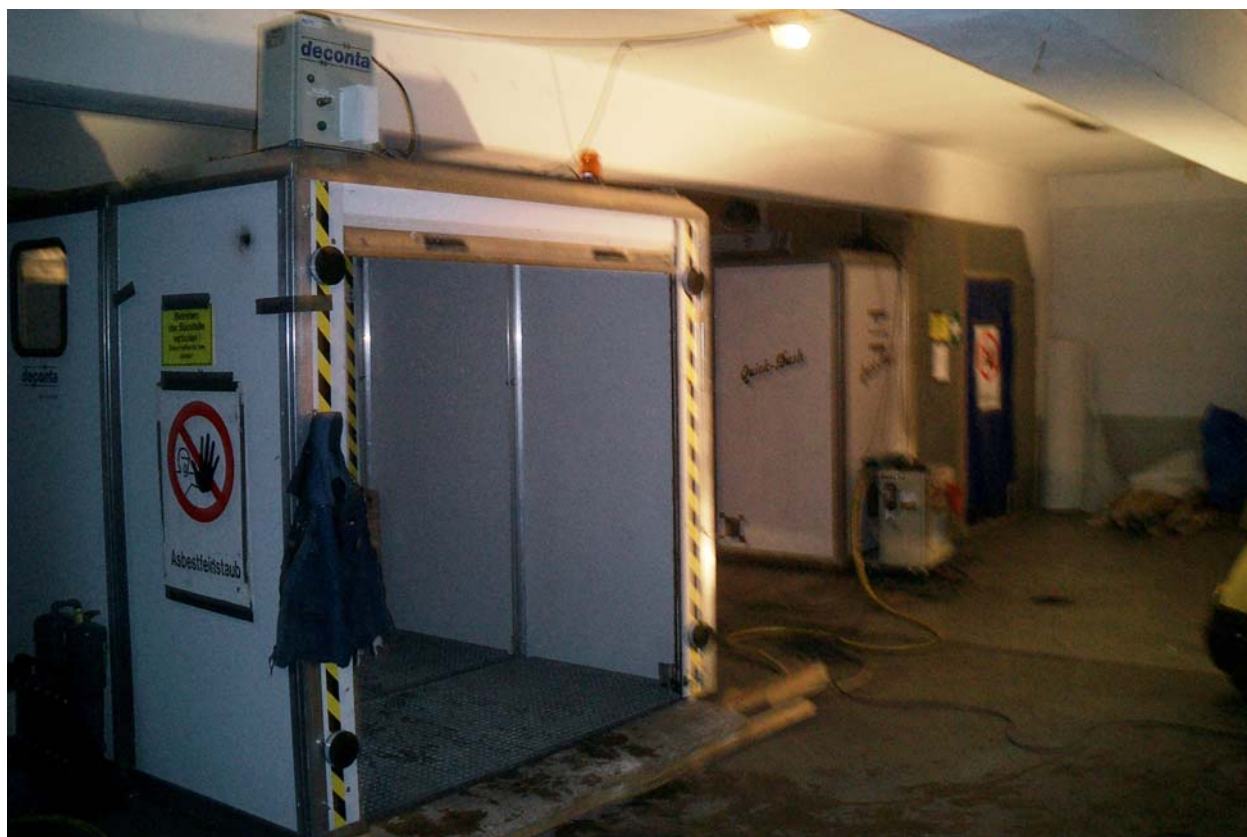
Materialschleuse mit Öffnungskontrolle und automatischer Verriegelung
