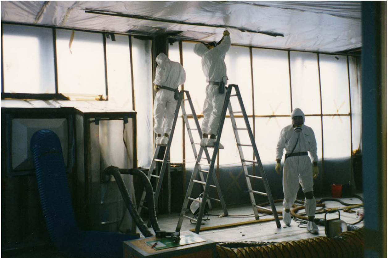
PCB-Sanierung
