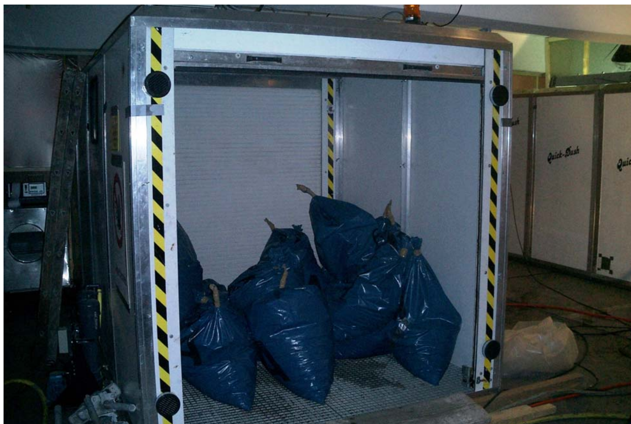
Ausschleusen von Asbestabfällen mit Materialschleuse
