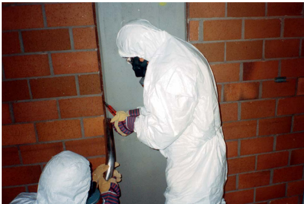
PCB-Fugensanierung
