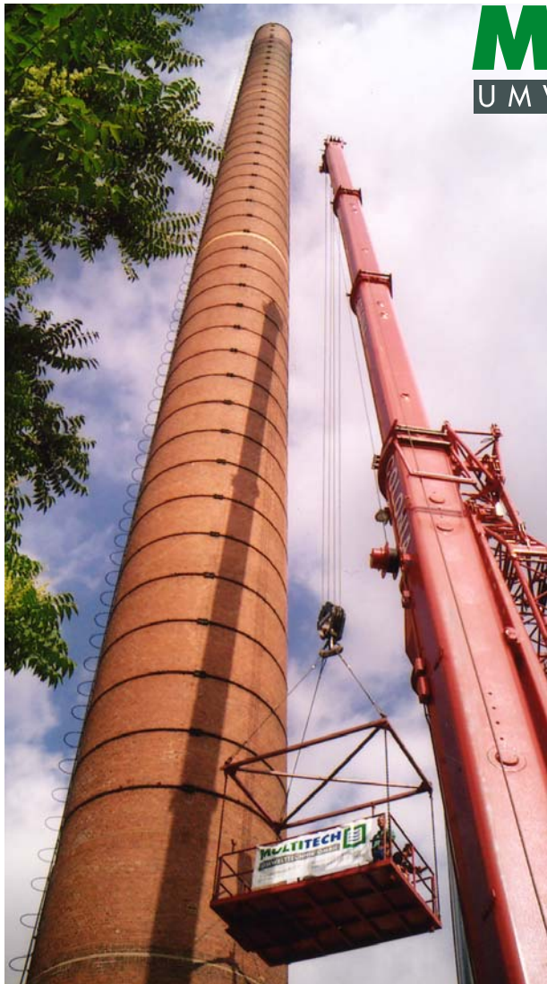
Baustelleneinrichtung für Schornstein-Handabbruch
